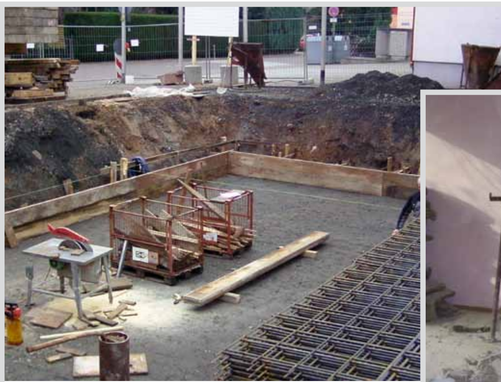
Oben: Am 9.12. haben die Bauarbeiter die Schalung für die mächtige Bodenplatte erstellt. Nach dem Einbau von Wärmedämmung und Bewehrung kann die Platte betoniert werden. Rechts: An dieser Stelle – das ehemalige Steueramt im Erdgeschoss – werden die neuen Besuchertoiletten entstehen.
