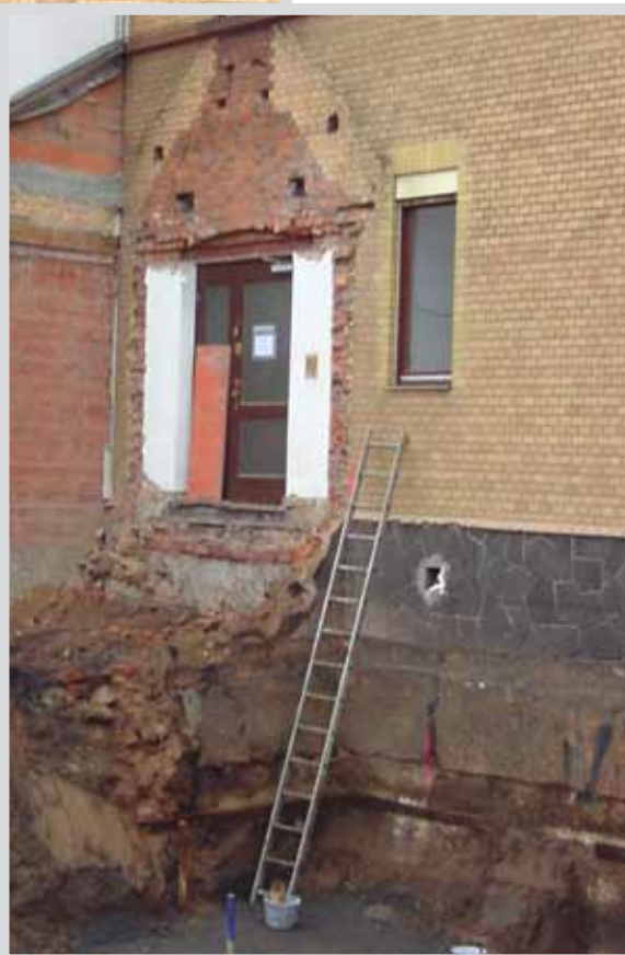
Oben: Da der Keller des Neubaus tiefer liegt als die Fundamente der beiden alten Gebäude, müssen die Fundamente unterfangen und gesichert werden. Rechts: Der alte Haupteingang nach dem Abbruch Anfang Dezember.
