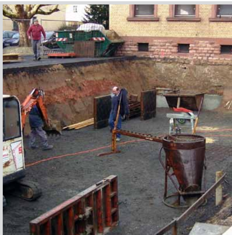
Oben: Da der Keller des Neubaus tiefer liegt als die Fundamente der beiden alten Gebäude, müssen die Fundamente unterfangen und gesichert werden. Rechts: Der alte Haupteingang nach dem Abbruch Anfang Dezember.
