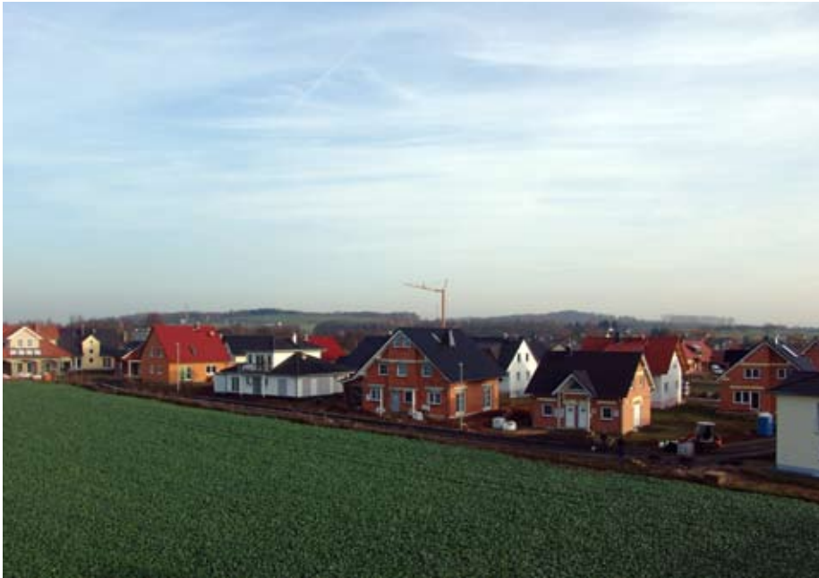
Blick auf das Neubaugebiet „Limes III“: Die ersten Häuser sind bereits bezogen
