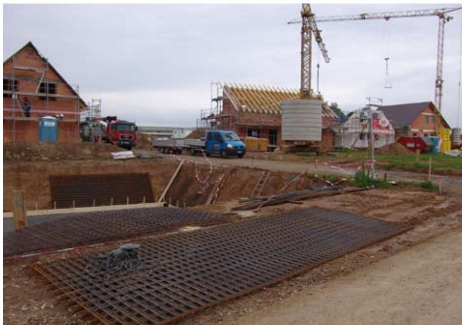
Baukräne, LKW und Dixie-Klo: Im Baugebiet Limes III geht's voran
