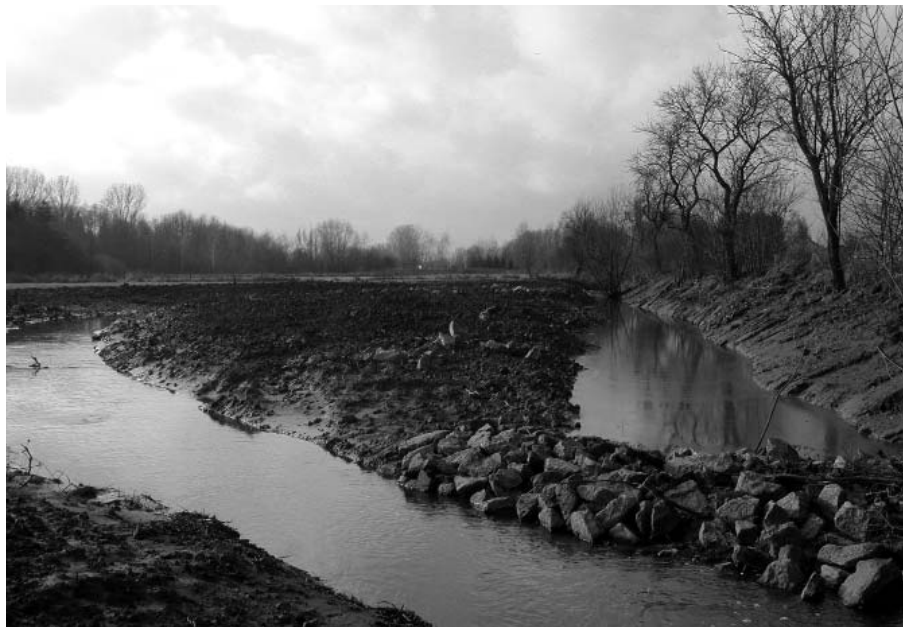
Die Fallbachaue unmittelbar nach Abschluss der Renaturierungsmaßnahmen
